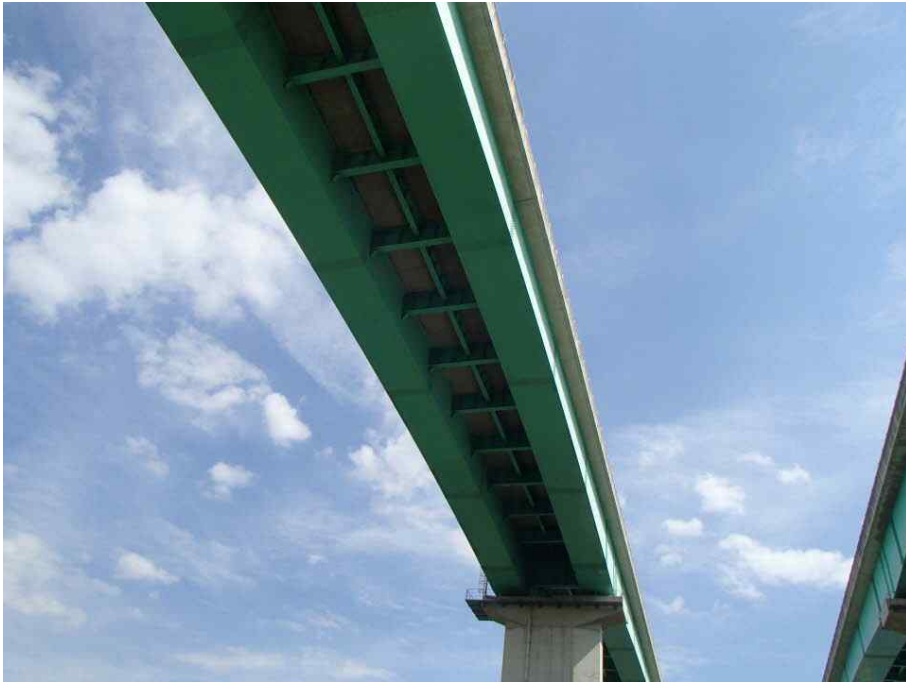
Steel Box Girder 외부 전경
